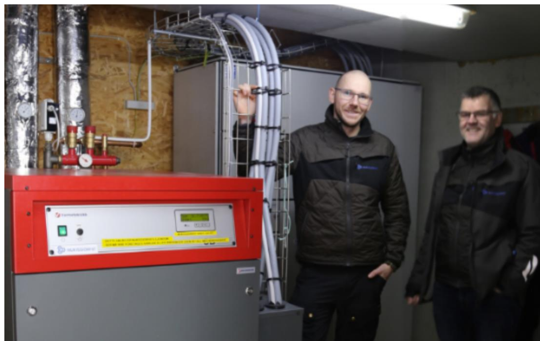
Figur 8: Igangsættelse af en elektrokedel på Hotel SØMA i Nuuk, som erstatter brug af fyringsolie og sparer 142 ton CO 2 om året (Nukissiorfiit, 2024b)
