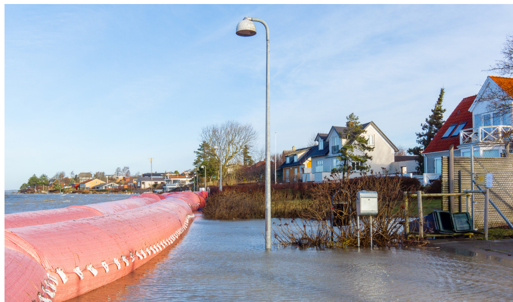
Lyserødt afløb mod stormen Urd i Frederikssund, Danmark Kilde: Adobe Stock, Stig Alenas
