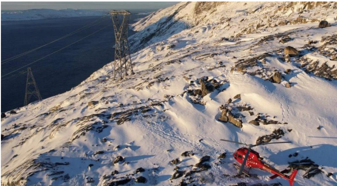
Figur 10: Ved nedbrud i elnettet, skal teknikere vente på vejrforhold, der gør det muligt at benytte helikopter til at reparere kablerne.
