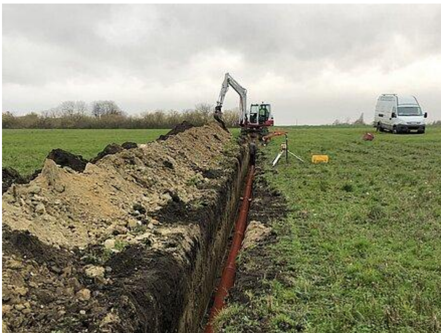
Figur 5. Dræning af mark (Enghavens Entreprenør og Kloarkmester, 2025). I de fleste arealer opnås den bedste drænvirkning ved en drændybde på omkring 1,0-1,2 m, som er ideel for de fleste afgrødetyper. (SEGES, 2015).
